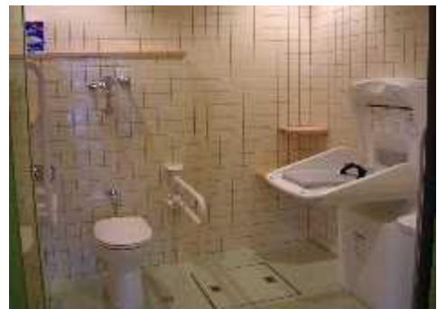
広い多目的トイレの内部
