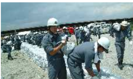
6月9日物部川河川敷で水防訓練土のう積みをしました。
